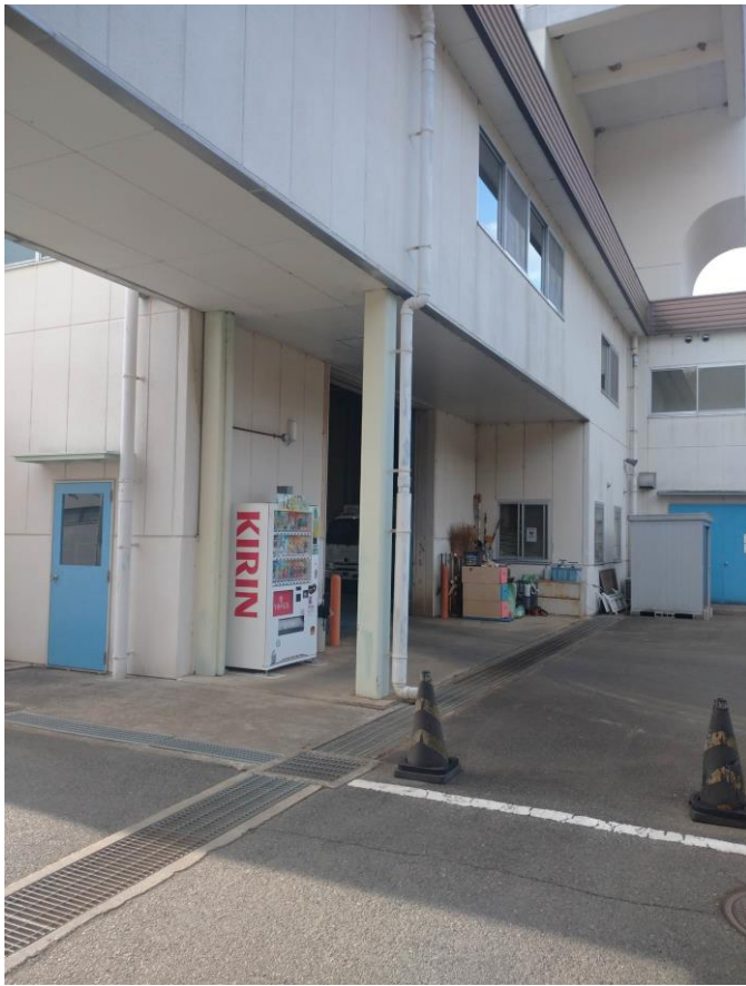
現在の設置状況写真①
