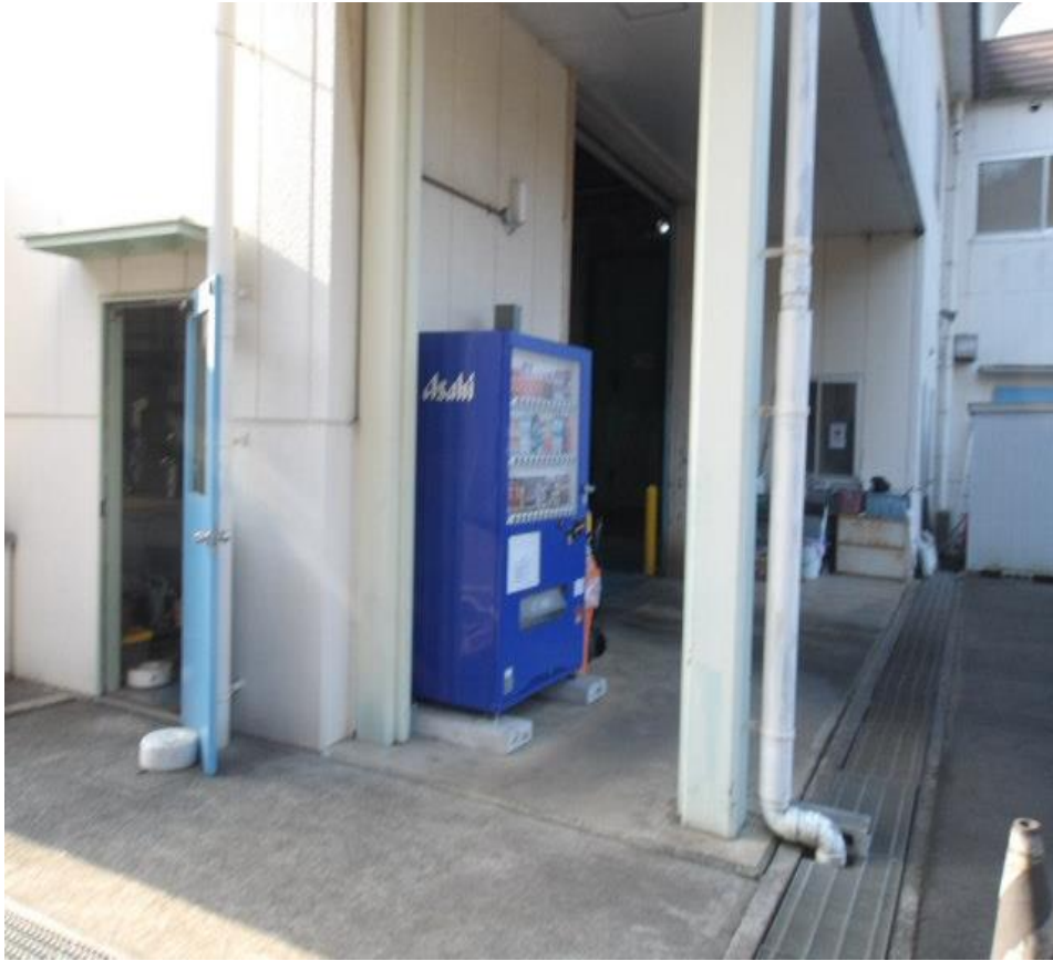
現在の設置状況写真①
